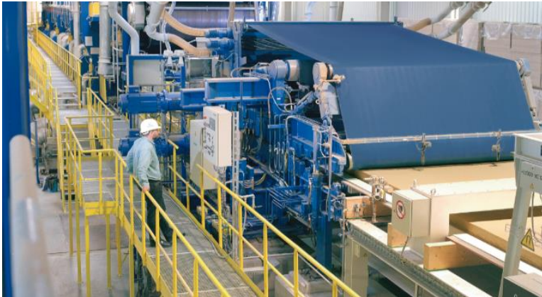
BUDOWA WŁASNEJ FABRYKI PŁYTY WIÓROWEJ
